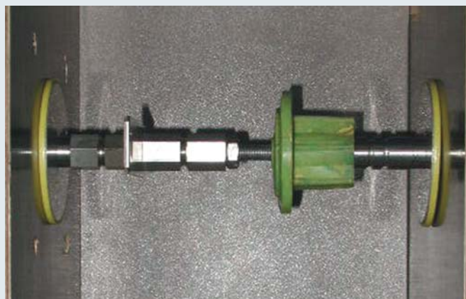
Рис. 1: Ввод через стену с монтажом в опалубку
