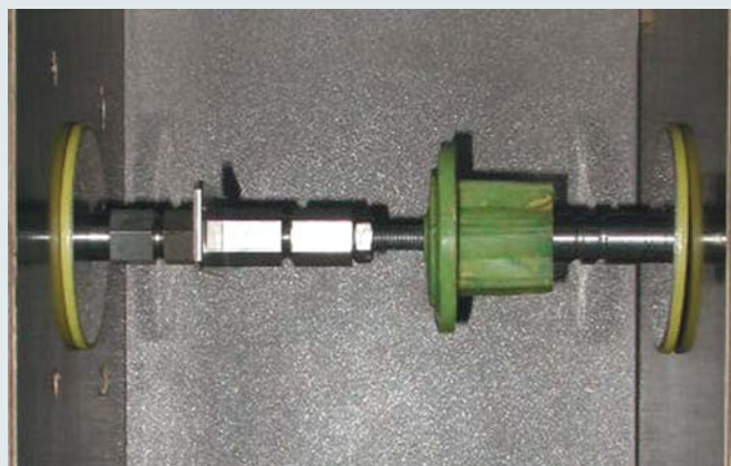
Рис. 1: Ввод через стену с монтажом в опалубку
