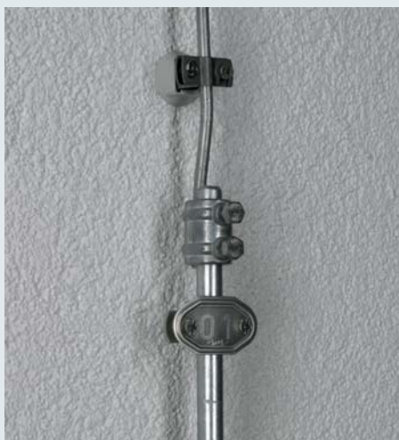
Стержень земляного ввода в комплекте с разделительной муфтой и соединительными клеммами тип KS
