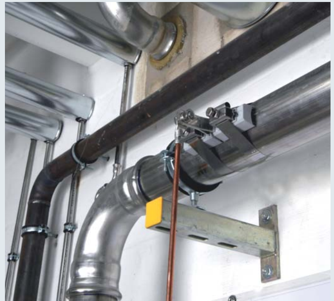
Применение на трубе из нержавеющей стали.
