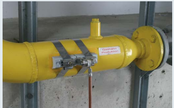
Ленточный хомут для включения труб во взрывоопасных зонах в систему молниезащитного уравнивания потенциалов согласно IEC/EN 62305-3
