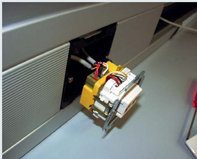
УЗИП для телекоммуникационных устройств для установки в распределительные коробки скрытого монтажа или небольшие распределительные щиты. Вход устройства снабжается вставными клеммами.
