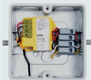
УЗИП DSM, установленное в распределительный щит скрытого монтажа
